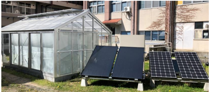
導入された太陽熱集熱器及び太陽光発電パネル
